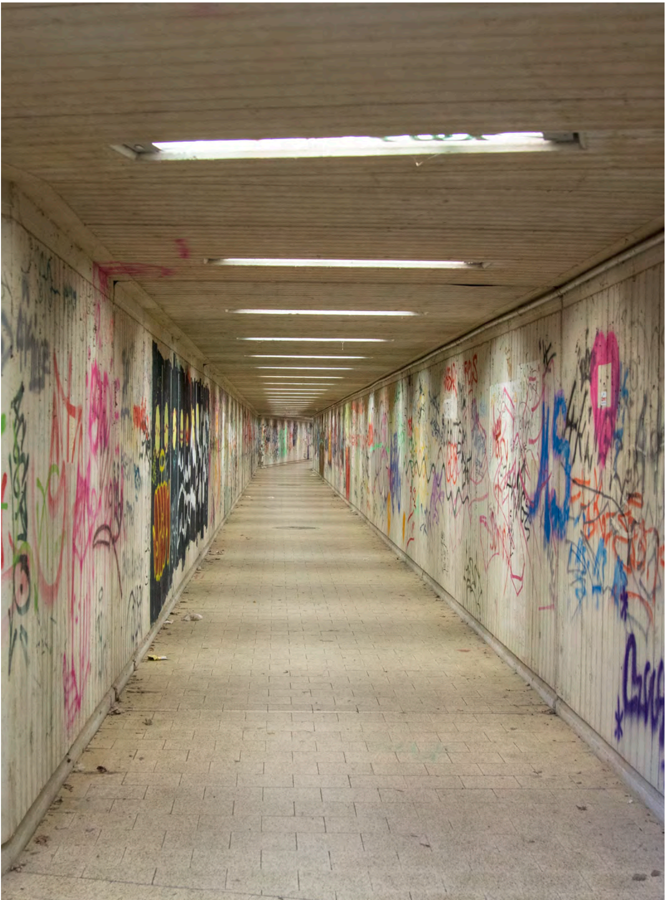
Abb. 085: Fußgängerunterführung am ehemaligen Güterbahnhof Grunewald, Quelle: C4C | CS
