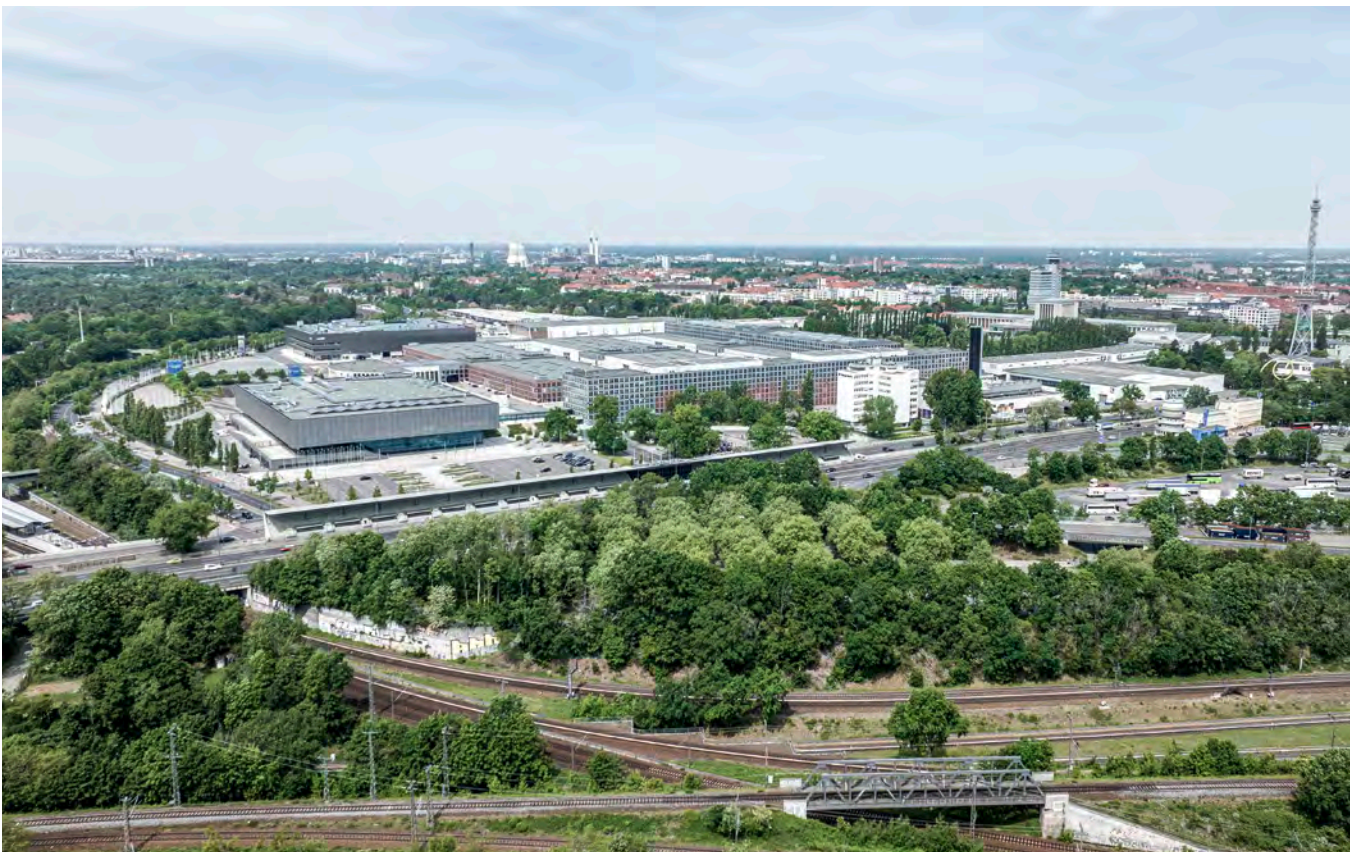
Abb. 066: Blick auf das Messegelände aus Richtung des ehemaligen Güterbahnhofs Grunewald, Quelle: Lookzoom Filmproduktion Berlin, 06/2022
