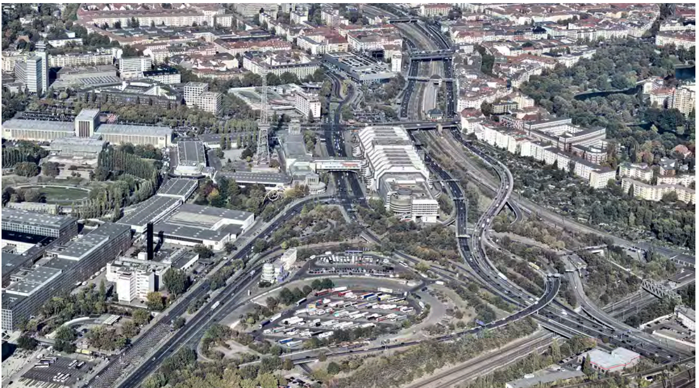
Abb. 019: Luftbild prägender baulicher Strukturen am Planungsgebiet (von links nach rechts): Messe, AVUS-Tribüne, Mercedes-Haus, Funkturm, ICC, Bebauung am Lietzen-see, Quelle: FOTOFRIZZ B.KUHN, 10/2018
