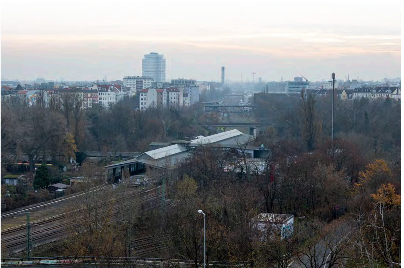
Abb. 091: Bahnhof Westkreuz, vom ICC aus gesehen, Quelle: C4C | CS, 11/2022
