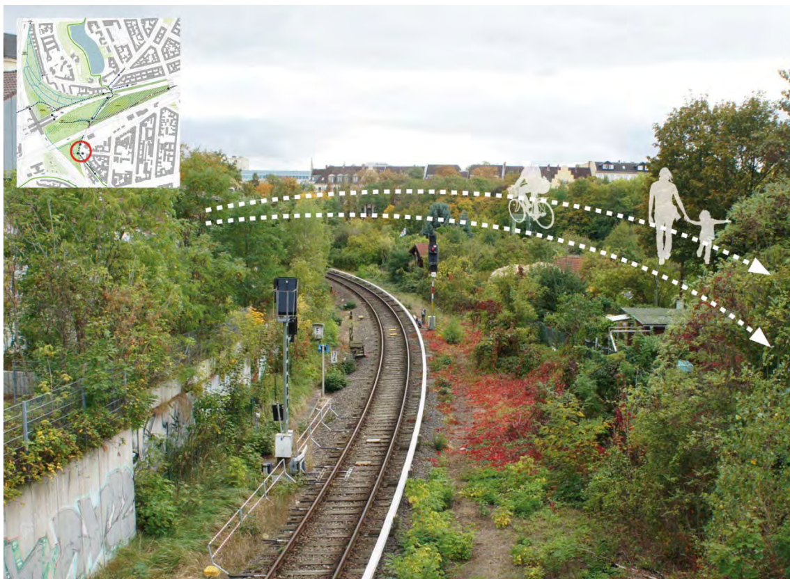
Abbildung 29: Brücke an der Lützenstraße / Ringbahnstraße (Blick nach Süden)
