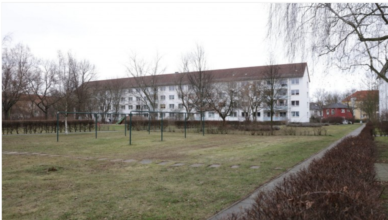
In den Innenhöfen der Ilsestraße wollte die Howoge Stadtvillen bauen (Foto: Frank Senftleben)
